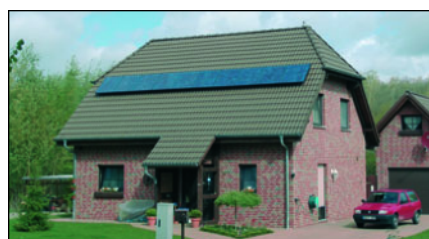
Bild 8: Kleine Anlagen in Aufdachmontage sind heute weitverbreitet. Sie sind einfach und kostengünstig zu montieren
