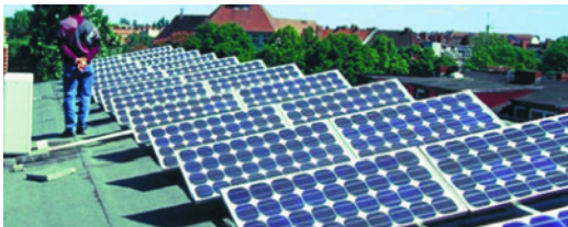
Bild 10: Bei der dargestellten waagerechten Flachdachmontage auf einem Bitumendach sind die Windangriffskräfte besonders niedrig (Foto: B. Breid)
