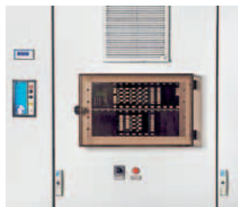
Von links nach rechts: modernisiertes Heizhaus mit neuen Brennern, Brenner mit aufgesetztem Frequenzumrichter, Steuerung der Mehrkesselregelung mittels SPS
