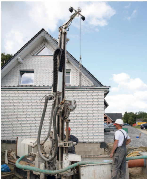
Erdsondenbohrung
