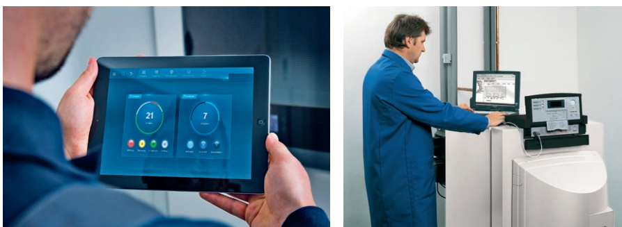
Abb. 4: Die Heizung kann über ein Tablet oder einen Computer einfach überwacht werden, wo und wann der Fachhandwerker will
