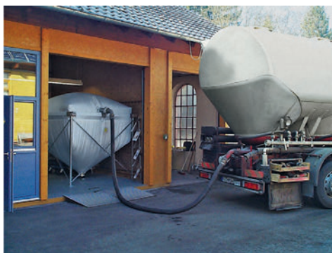
Bild 7: Die Lieferung der Pellets erfolgt in Tankwagen.
