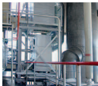
Von links nach rechts: Dampfkessel mit Economiser und Rauchgaskondensator, Dampfkessel vor Umrüstung, Rauchgaskondensator und Economiser
